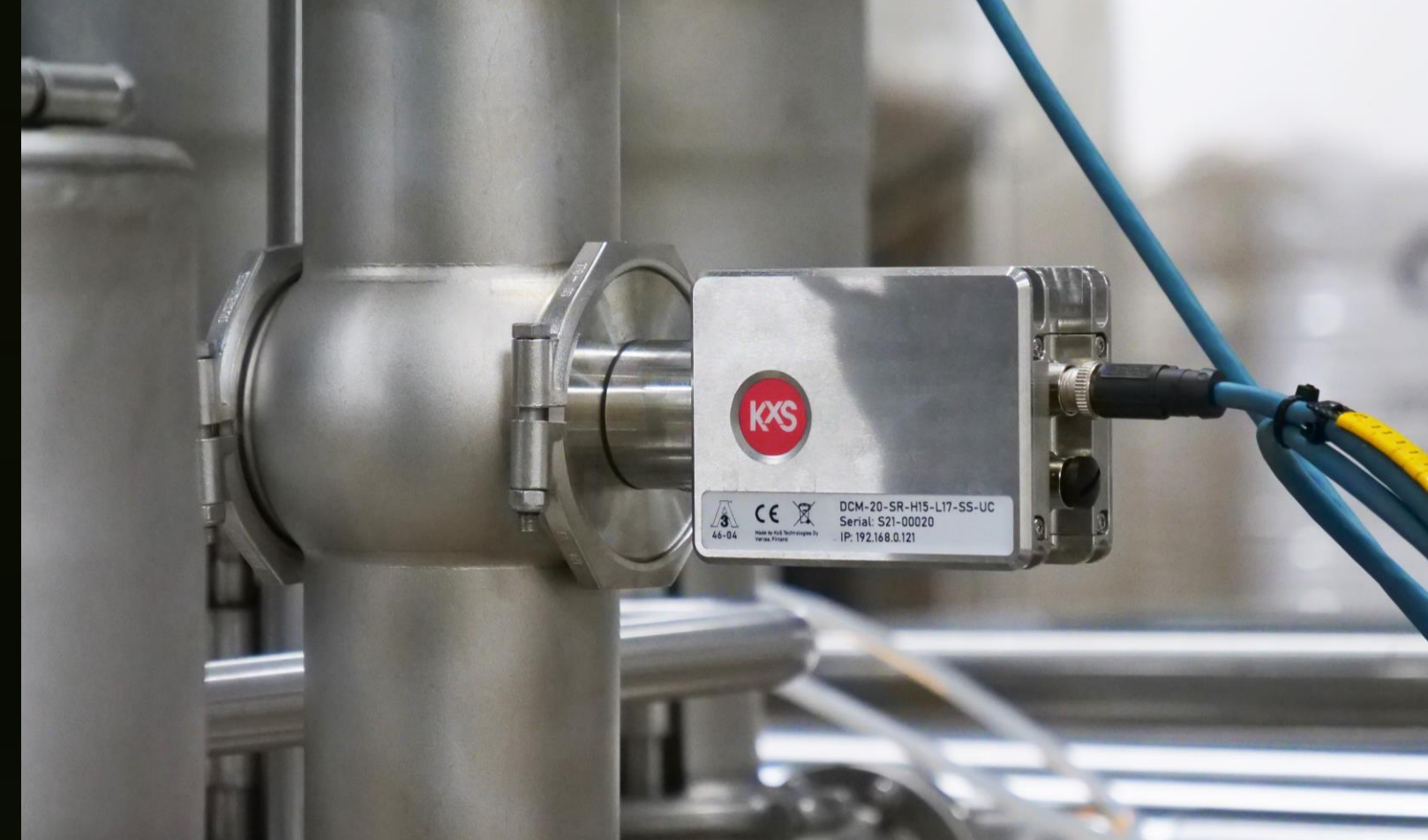
DN80 Ячейка Varinline
